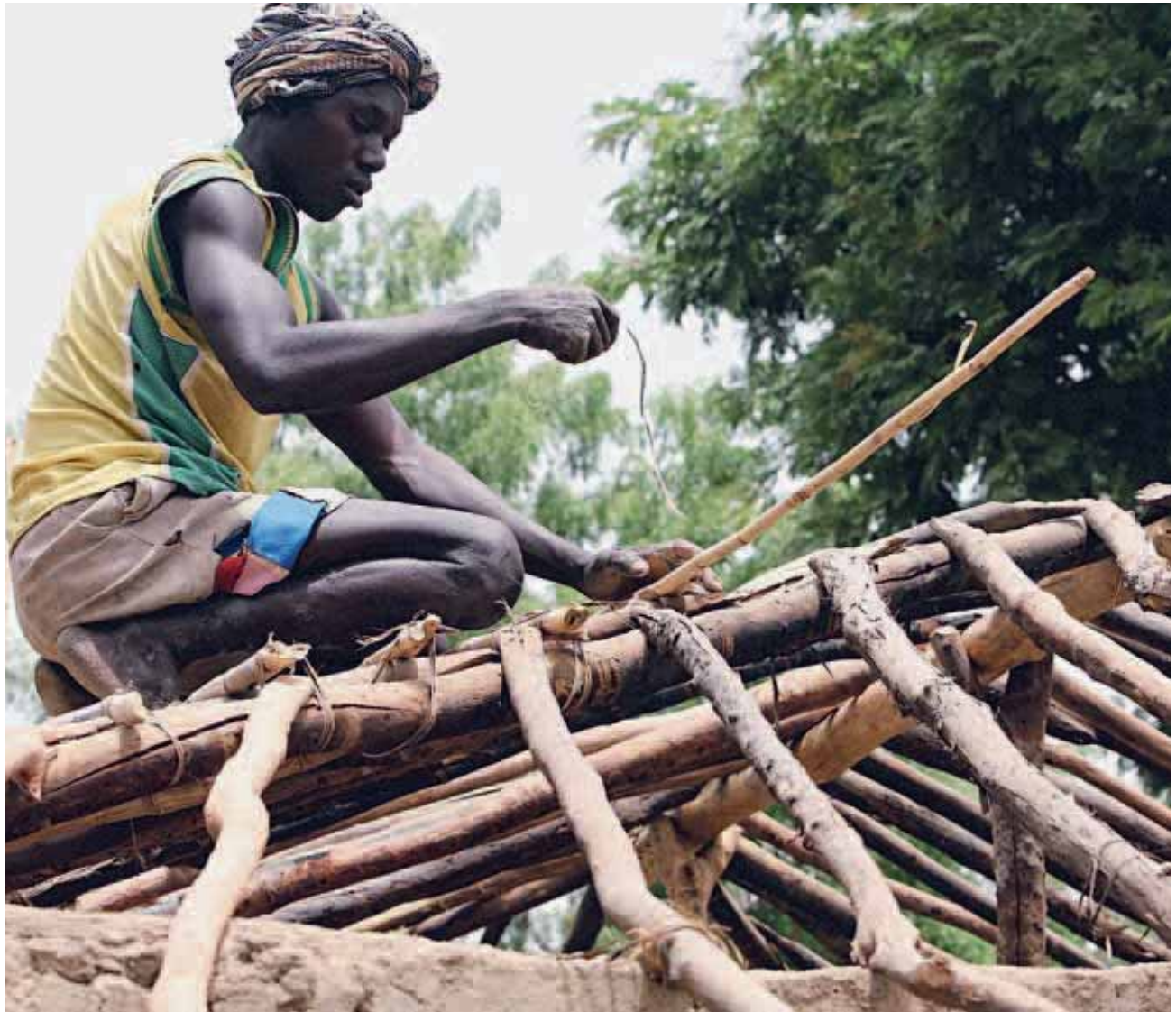
▲ Construction d'un toit, République Centrafricaine. ©Anthony Morland/IRIN
