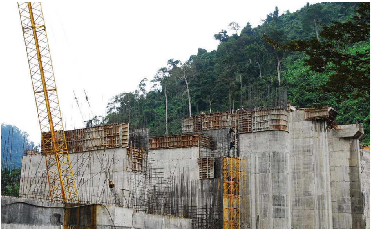
Xây dựng nhà máy thủy điện A Vương © UBND tỉnh Quảng Nam
