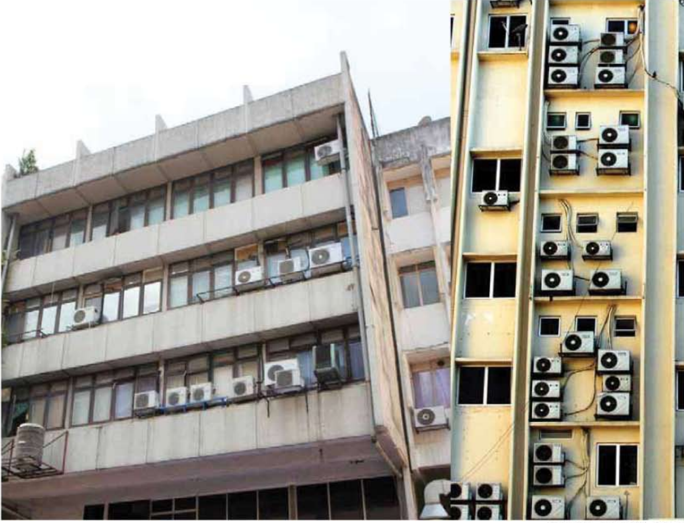
أجهزة التكييف لا تساهم في رفع كفاءة المباني.
