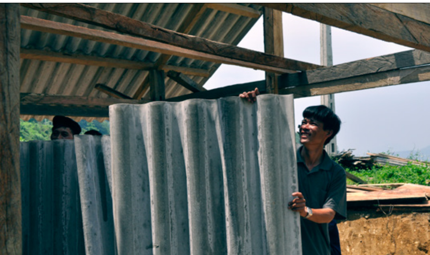
Hình 7: Hộ cá thể tự xây nhà tại Bắc Ninh
