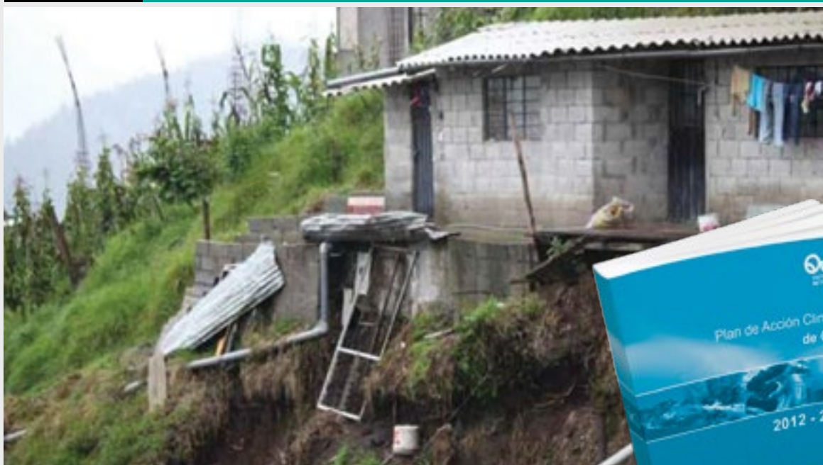
Logement précaire construit sur une pente raide à Quito © Agencia Pública de Noticias de Quito
