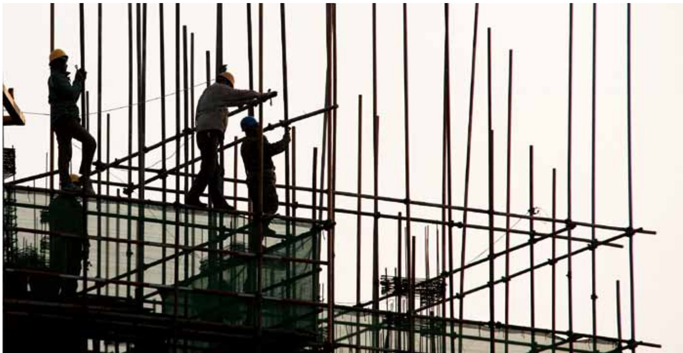
建筑工地上的农民工（李龙摄）
