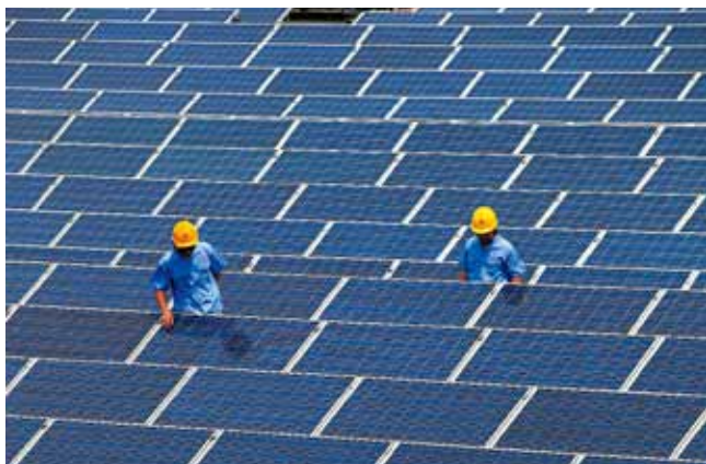
正在检测光伏电站的工人 (梁孝鹏 摄)
