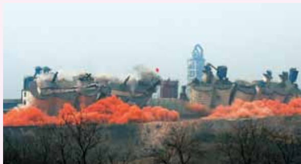
石家庄某水泥厂爆破拆除（赵威摄）
