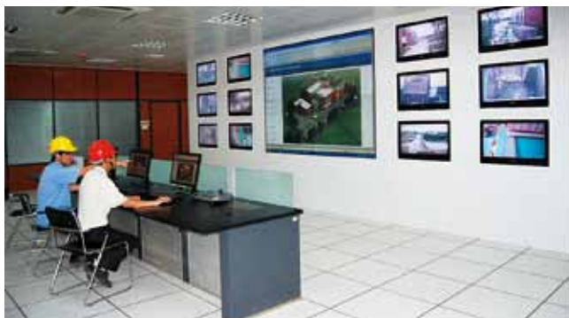
(1) 中转站集中控制室
