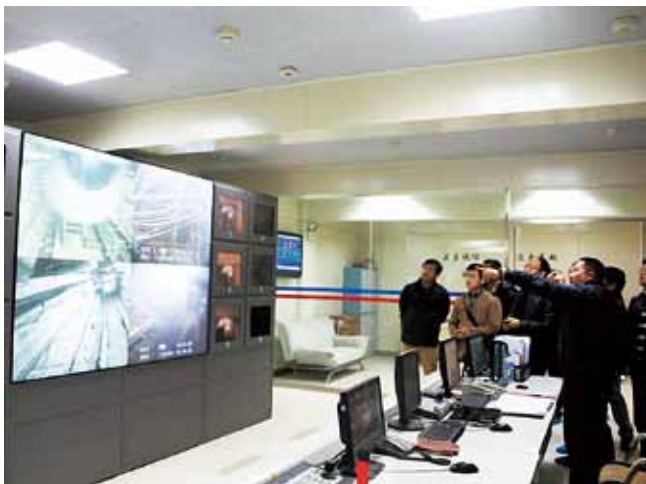
昆明市广福路综合管廊及监控中心 (来源：云南省住房和城乡建设厅网站)
