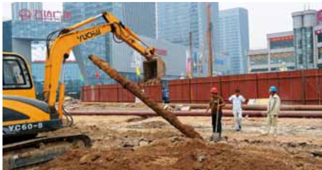
廊坊城市供水管道更新改造（李宗来 摄）
