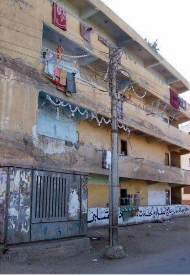
شكل (٢٧) حالات المباني المختلفة بالمدينة
