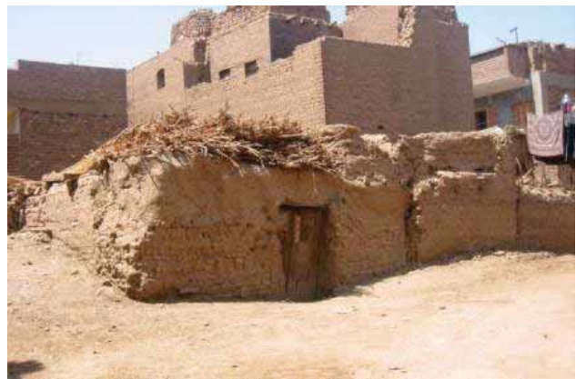
شكل (٢١) المباني الرديئة بالمدينة
