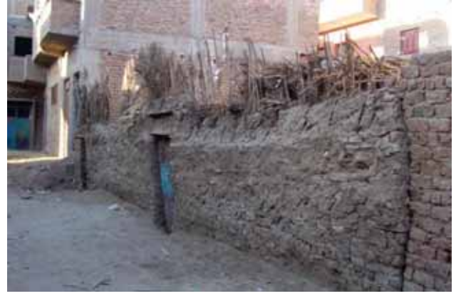
شكل (٢٥) حالات المباني المختلفة بالمدينة
