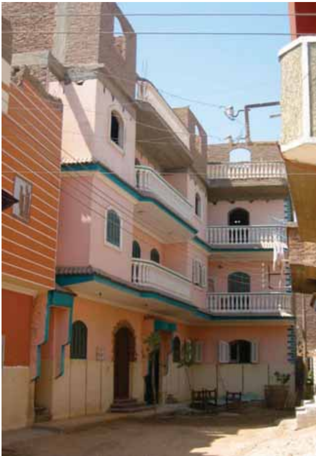
شكل (٣٥) حالات المباني الجيدة بالمدينة
