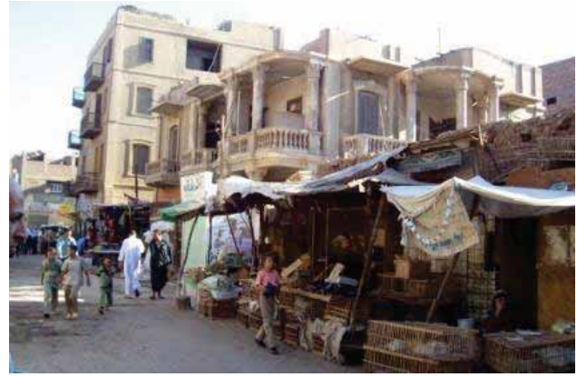
شكل (٢٩) حالات المباني المختلفة بالمدينة
