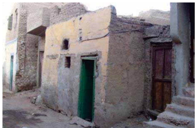
شكل (٢٤) المباني الرديئة بالمدينة
