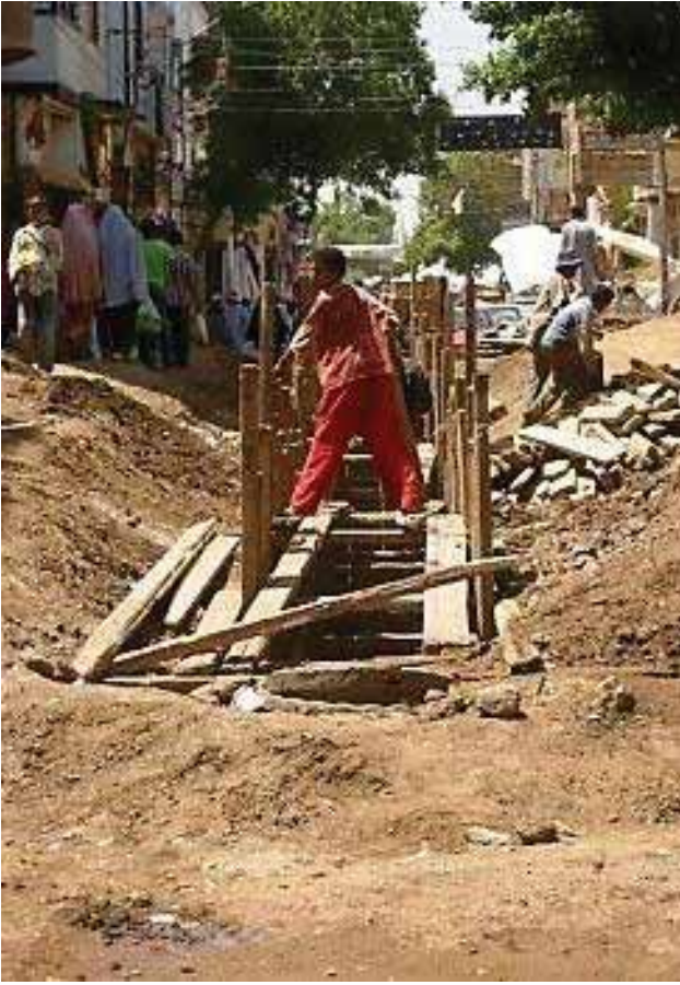
شكل (١٧) مشروع الصرف الصحي الجاري تنفيذه بالمدينة
