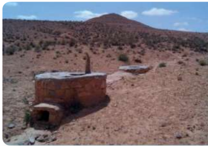
Cistern in Tunisia. (M. Ouessar)
