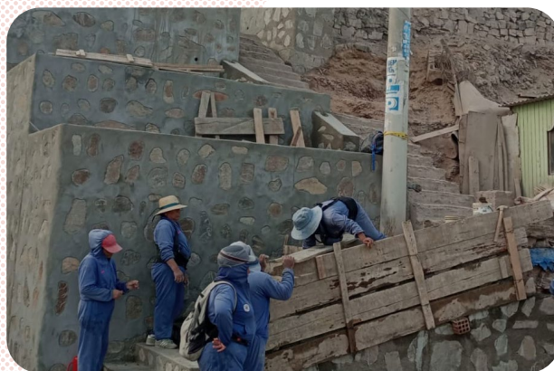
Trabalho de construção realizado por mulheres durante o projeto © UN-Habitat
