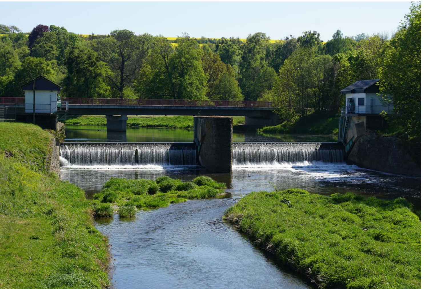
Photo 13: Weir White Elster Bad Köstritz © Stadt Bad Köstritz
