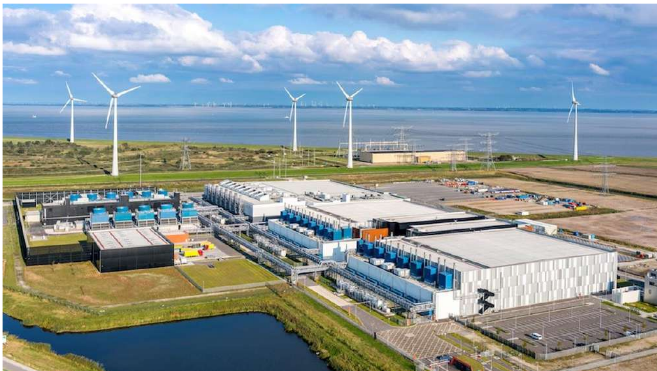
图 5-10 谷歌在欧洲建立的绿色数据中心 来源 Sustainableitdecoded withgoogle.com
