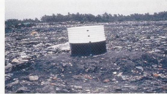
廃ドラム缶を使ったガス抜き設備
