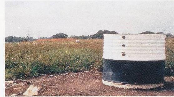
ガス抜き設備の効果により、植生が回復
