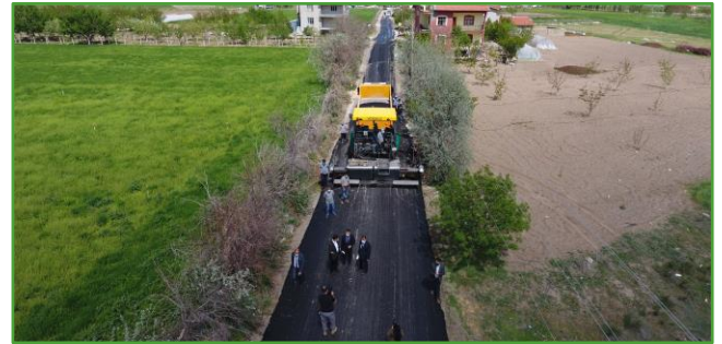
Fotoğraf 12: Karatay İlçesi Mahallelerinde Sathi Kaplama Çalışmaları
