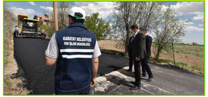
Fotoğraf 11: Karatay İlçe Merkezi Sokak Asfaltlama Çalışmaları
