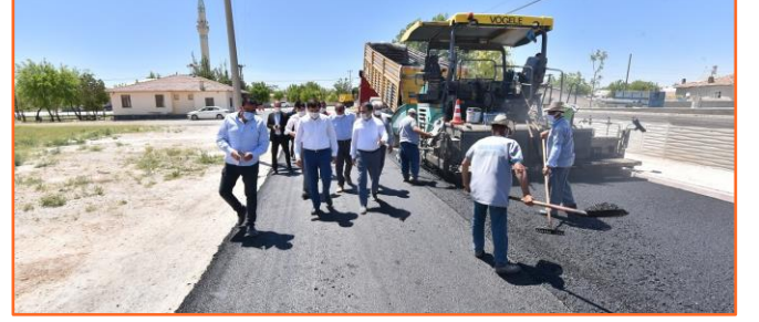
Fotoğraf 53: Asfalt Çalışmaları
