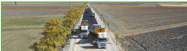
Fotoğraf 10: Merkeze Uzak Mahallelerde Sıcak Asfalt Çalışması
