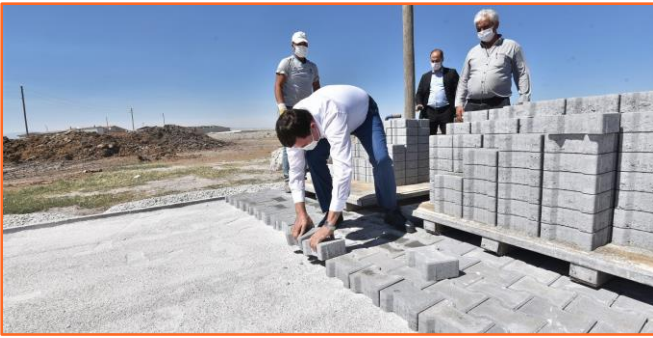
Fotoğraf 52: Karatay İlçesi Parke Çalışmaları
