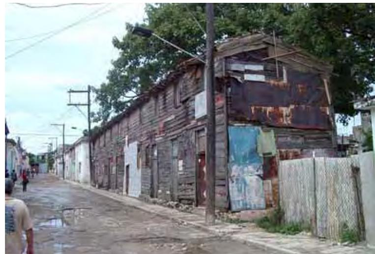
FIGURA 13: **Tipología V con paredes de madera rústica en el barrio El Canal, La Habana.**
