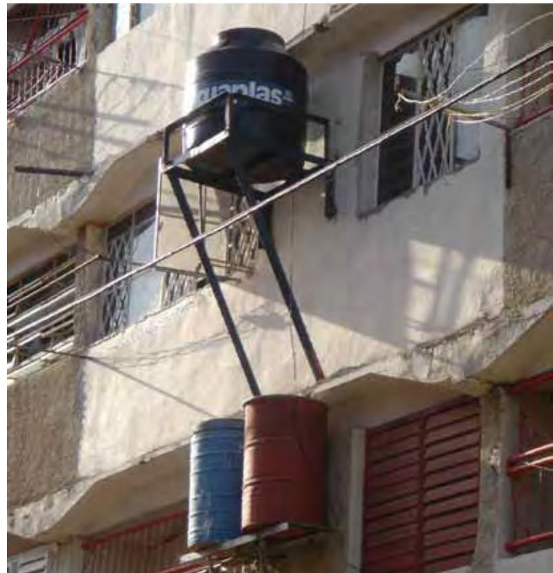
FIGURA 40: Se colocan tanques de agua personales para mitigar inestabilidades del servicio de agua
