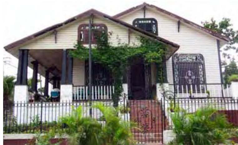
FIGURA 11: **Tipología IV con paredes de madera aserrada en el barrio Vista Alegre, Santiago de Cuba.**
