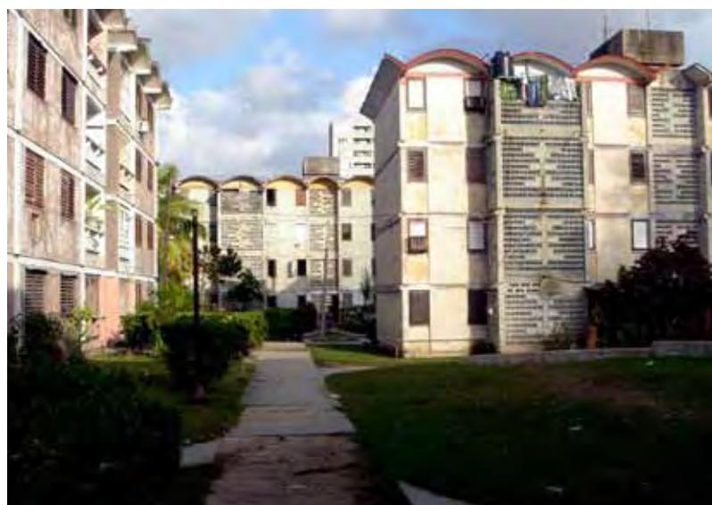
FIGURA 9: Tipología II con techos de bóvedas de ladrillo
