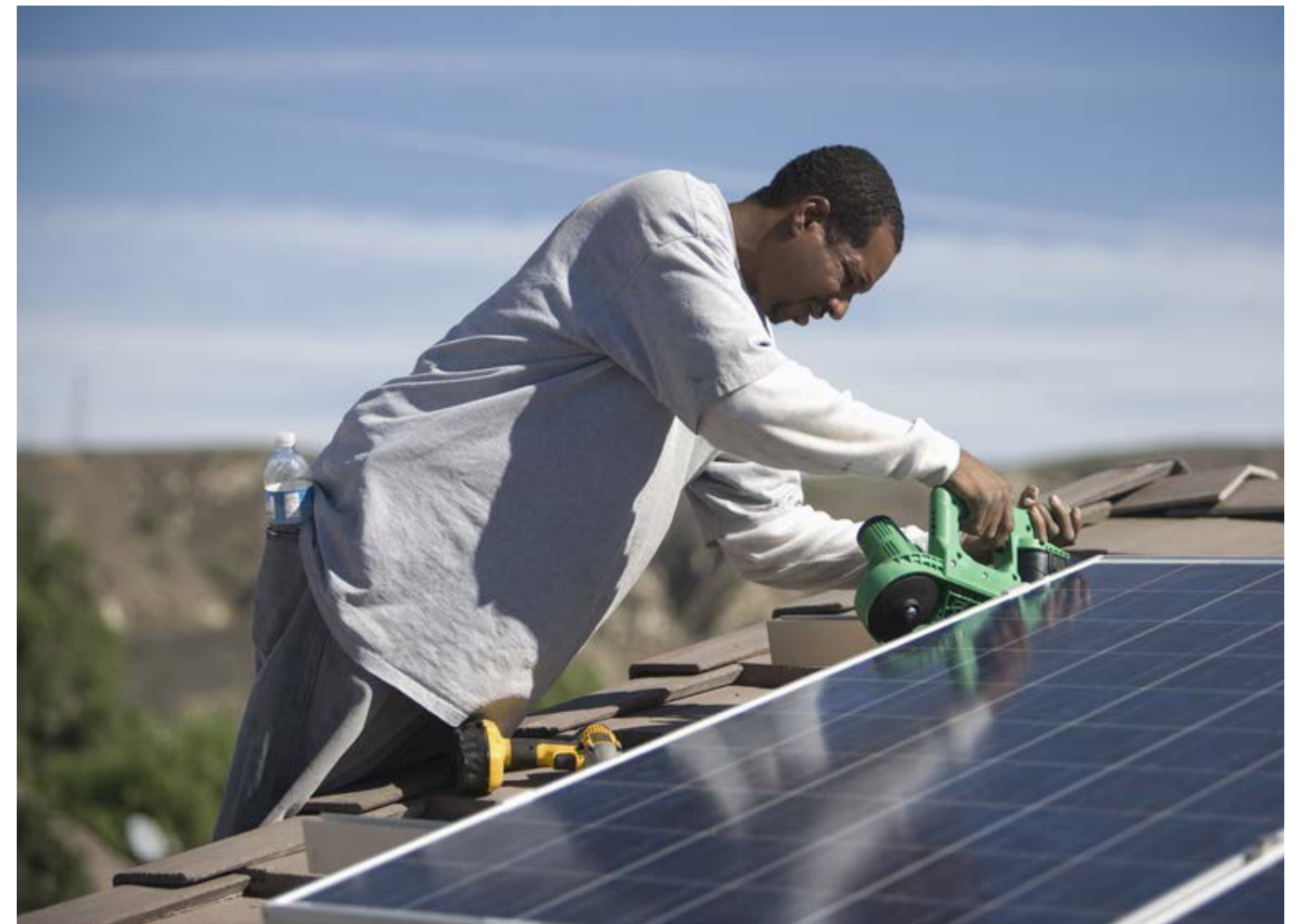
Fig.4: Installation de panneaux photovoltaïques autonome comme approche alternative pour augmenter l'accès à l'électricité
