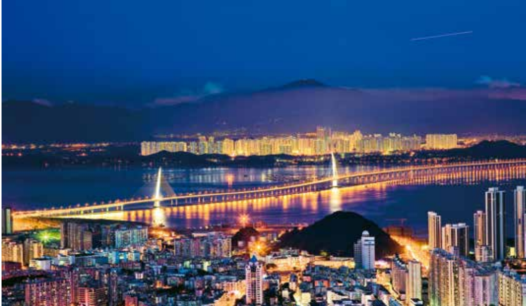
Shenzhen Bay Bridge @SZAICE
