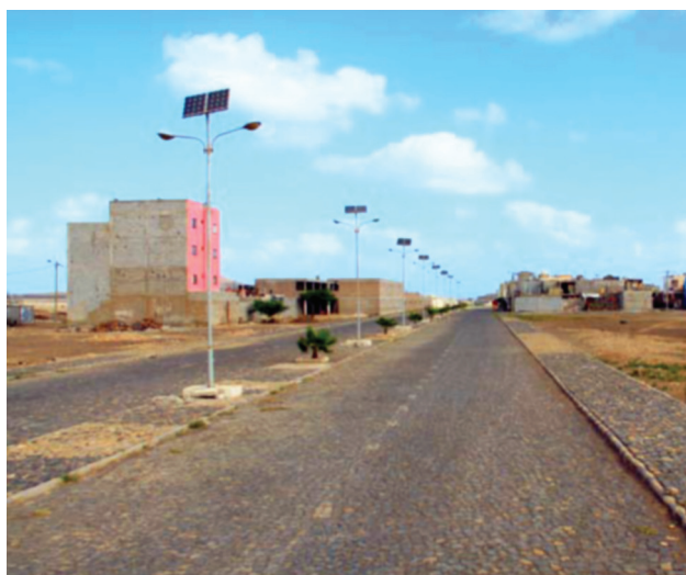
Infraestrutura Rodoviária da Cidade dos Espargos
