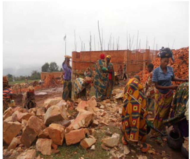
Construction d'une nouvelle habitation en matériaux traditionnels.
