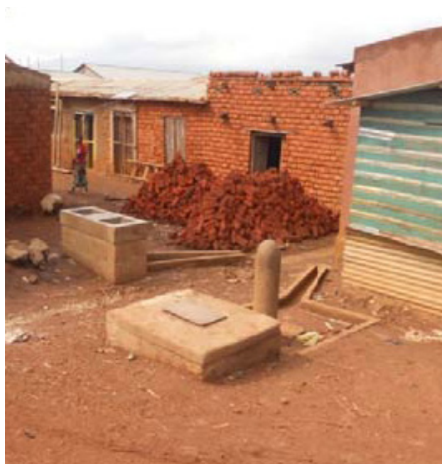
Installation d'une fosse septique et d'un système de drainage dans un des quartiers de la ville.
