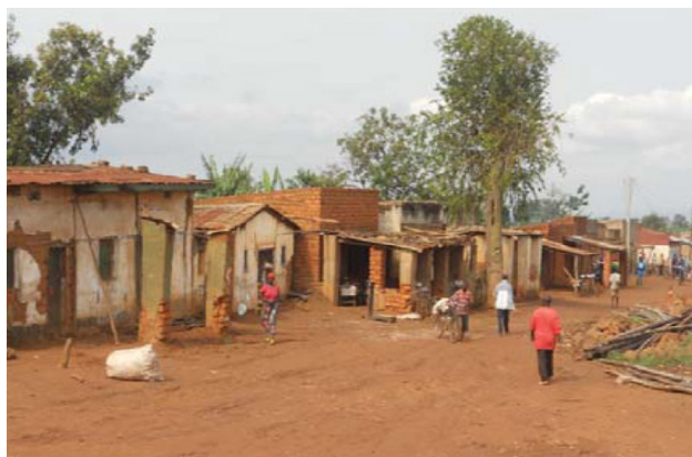
Exemple d'habitat au centre de Rutana.
